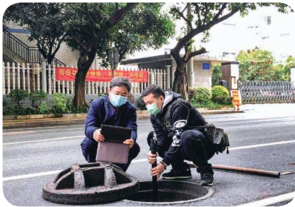
雨水管道排查
