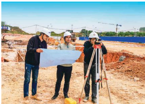
杨波在检查桩顶标高
