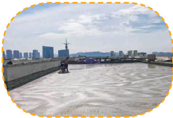
瑞声科技南宁产业园光学模组发展项目粉针剂车间屋面防水工程
